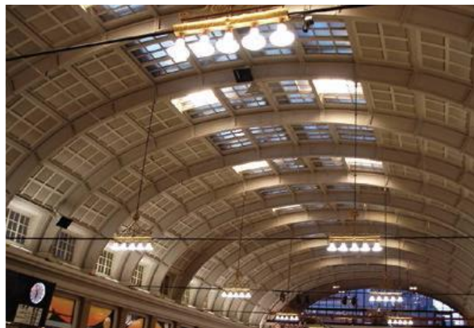
شکل ۱۱-۲ سقف قوسی گلولام در ایستگاه مرکزی راه آهن استکهلم، ساخته شده در سال ۱۹۲۵
