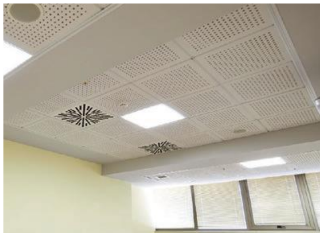
شکل ۸-۵ پنل های گچی برای عایق صوتی طراحی شده اند
