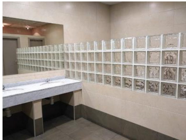
شکل ۱۰-۶ بلوک های شیشه ای در نقش دیوار غیر باربر
