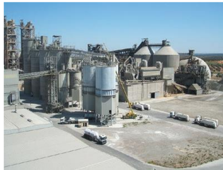
شکل ۴-۱ نمای کلی یک کارخانه سیمان
