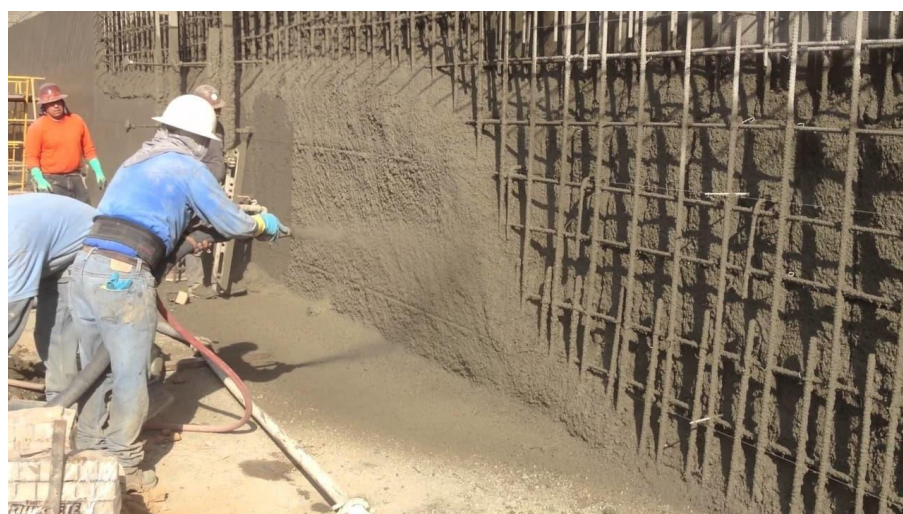
شکل ۶-۲۲ نمونه هایی از کاربرد شاتکریت
