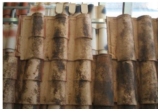
شکل ۹-۸ بافت سطحی برای تقلید از کاشی های سقف قدیمی
