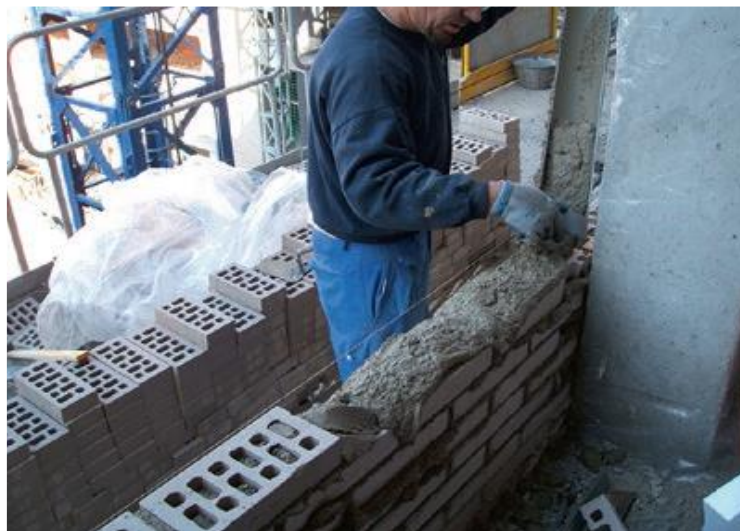
شکل ۱-۳ ملات بنایی مورد استفاده در ساخت ساختمان
